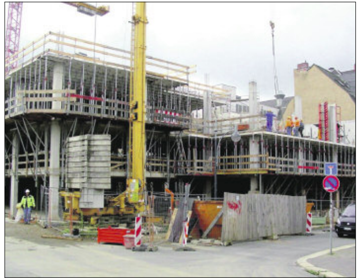
Bauarbeiten am Neubau Ecke Rädelsstraße / Forststraße
