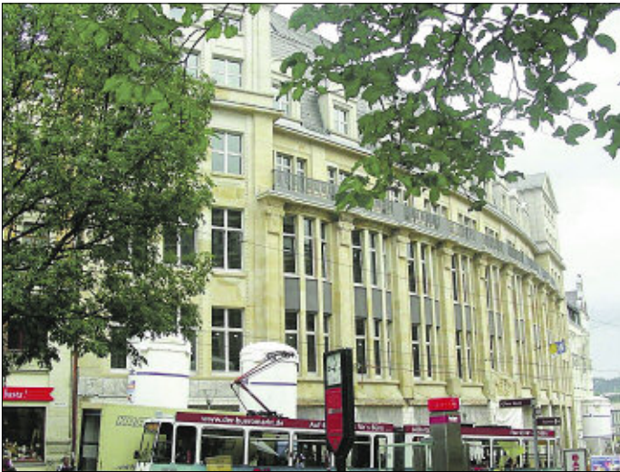
Sanierte denkmalgeschützte Ansicht am Postplatz
